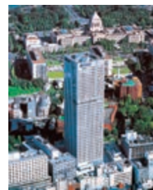
プルデンシャルタワー (東京・永田町)
